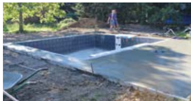
↳ Pose du revêtement
